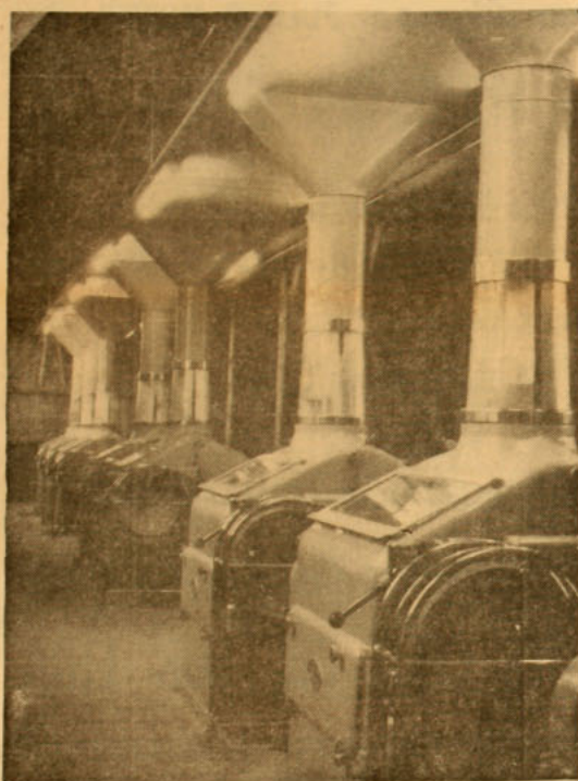
El moderno "MOLINO MUNDIAL" de Puerto Montt, propiedad de los progresistas industriales Carlos Stange y Kurt von Bischoffhausen, cuenta —como puede observarse en el grabado— con la última
